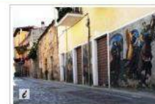
Comune di Orgosolo - Lavori di riqualificazione del centro storico di Orgosolo. Interventi di riqualif [...]
